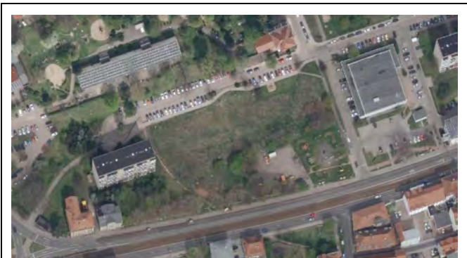
baulicher Bestand im Plangebiet, Luftbildauszug Quelle: geoproxy-geoportale Thüringen
