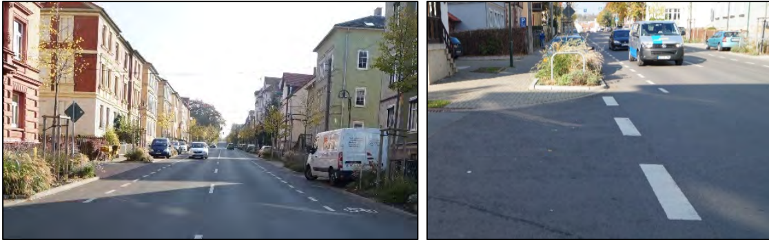
Abb. 7: Schutzstreifen auf der 18.-März-Straße
