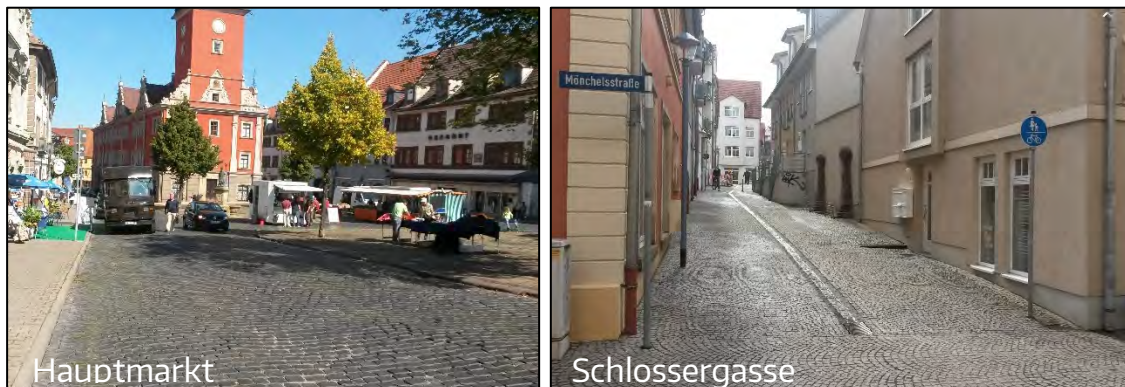
Abb. 23: Oberflächenbeschaffenheit innerhalb der Altstadt
