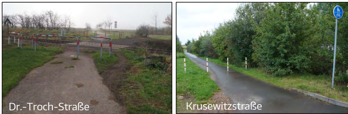
Abb. 21: Umlaufsperran an der Bahnquerung (links) sowie Poller (rechts)
