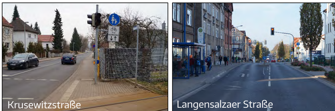
Abb. 11: Unterschreitung der Mindestmaße zur Freigabe für den Radverkehr
