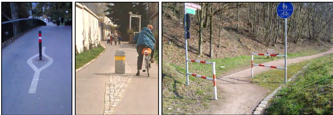
Abb. 28: Beispiele zur Verbesserung der Verkehrssicherheit an Pollern / Umlaufsperrn
