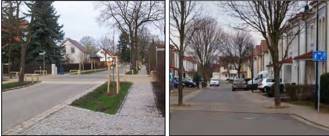
Abb. 19: Beispiele Plateauaufpflasterung / Baumtor (Erkner, Gotha Ahornweg)
