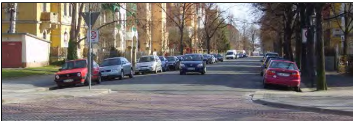
Abb. 33: Gehwegvorstreckung (Beispiel: Dresden)
