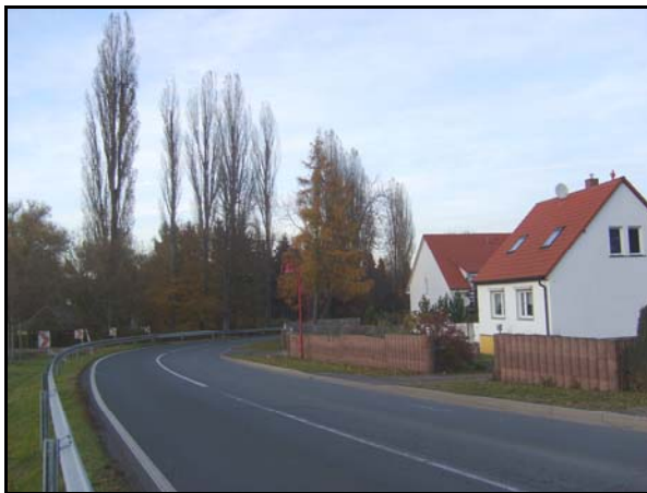
Abb. 36 Konfliktbereich Ortseingang Uelleber Straße
