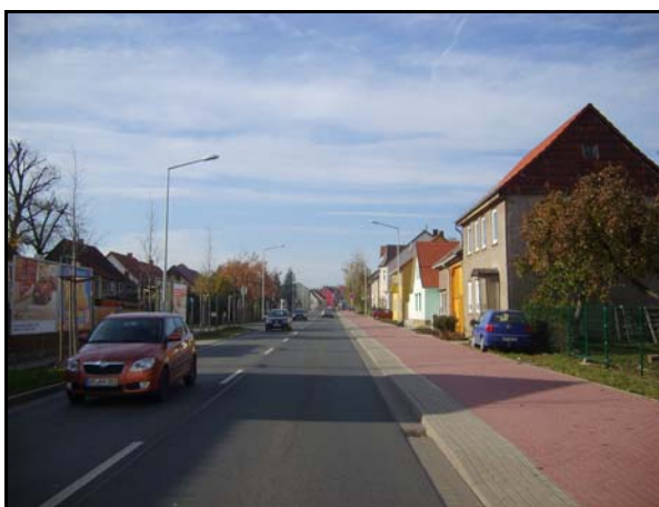
Abb. 37 Konfliktbereich Weimarer Straße / Mönchallee
