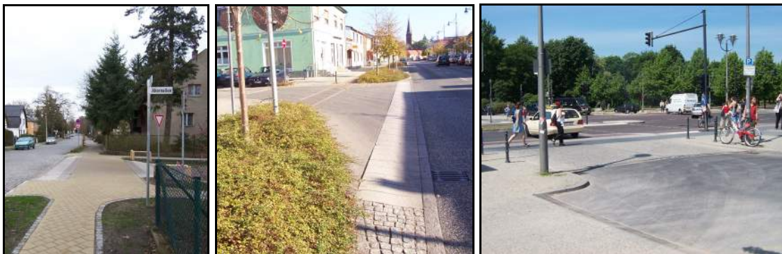
Abb. 44 Beispiele Gehwegüberfahrten bzw. -aufpflasterung (Erkner, Eberswalde, Berlin)
