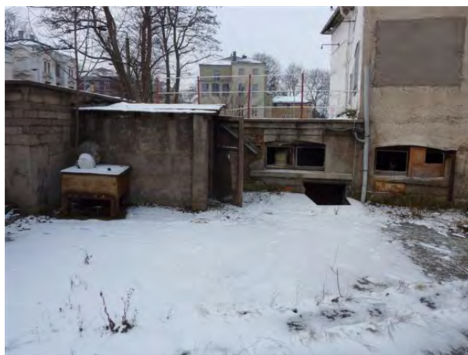
Zugang Heizungskeller, Blick nach West
