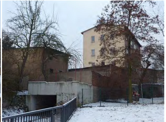
Auslauf Mühlgraben/Leinakanal Remstädter Straße
