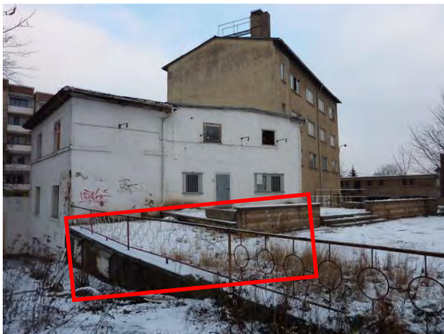
Heizungskeller (Ölheizung) vor dem Gebäude
