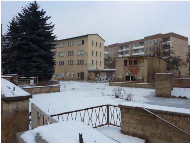
ALVF 3827: ehem. Ölmühle Blick von der Gartenstraße
