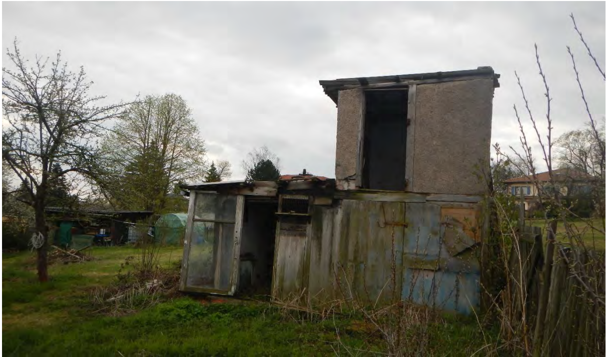
Abb. 3: Offenes Gebäude, für Fledermäuse ungeeignet, aufgrund von Zugluftverhältnissen
