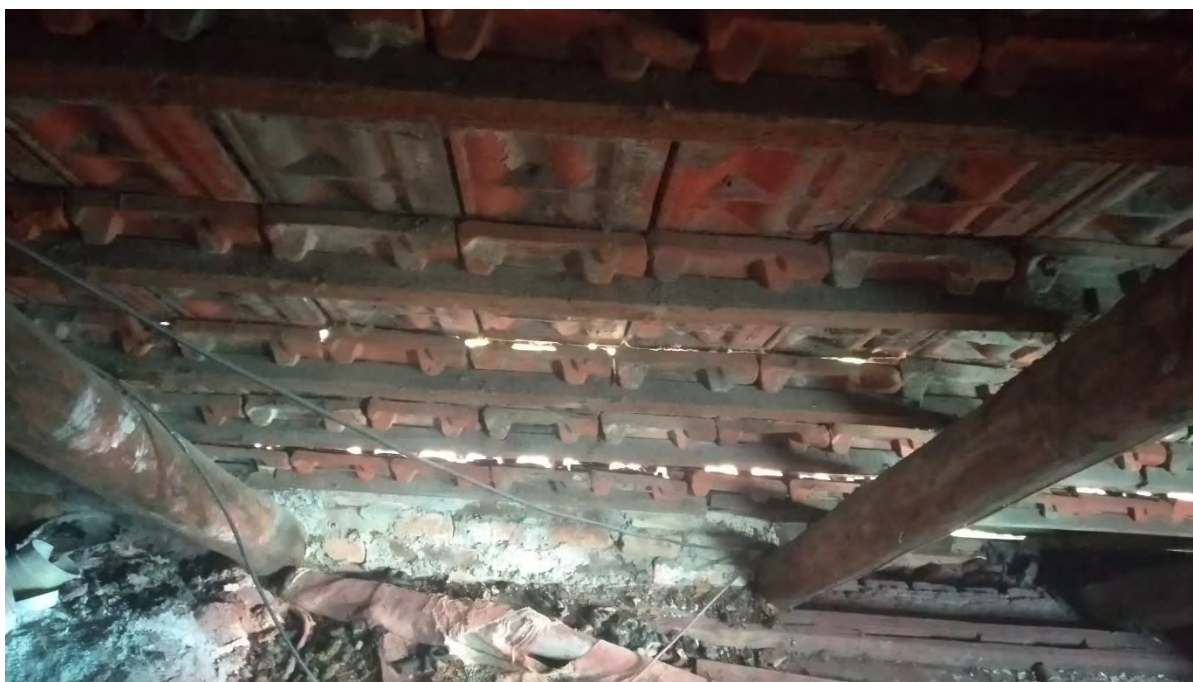
Abb. 6: Ungedämmter Dachstuhl
