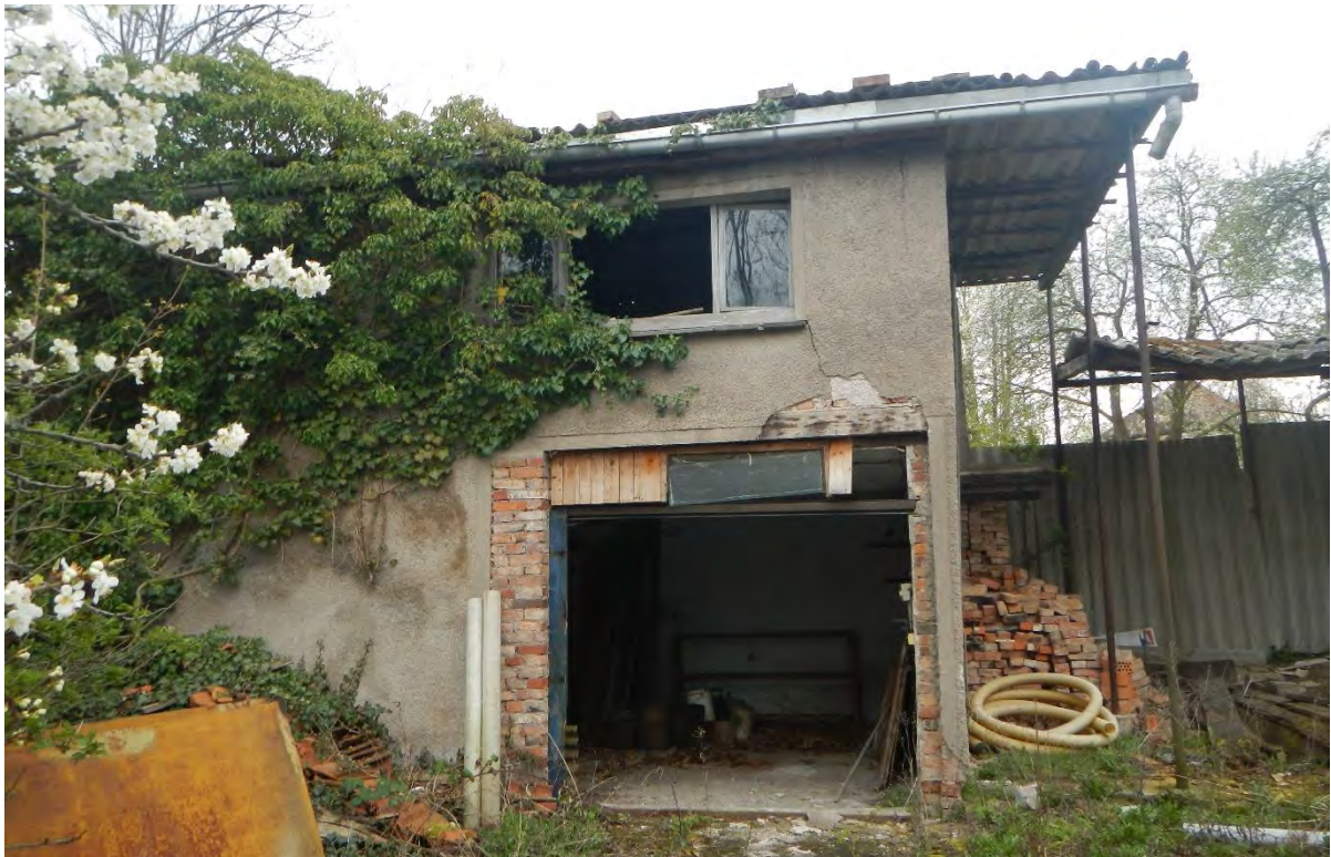
Abb. 4: Offenes Gebäude, für Fledermäuse ungeeignet, aufgrund von Zugluftverhältnissen
