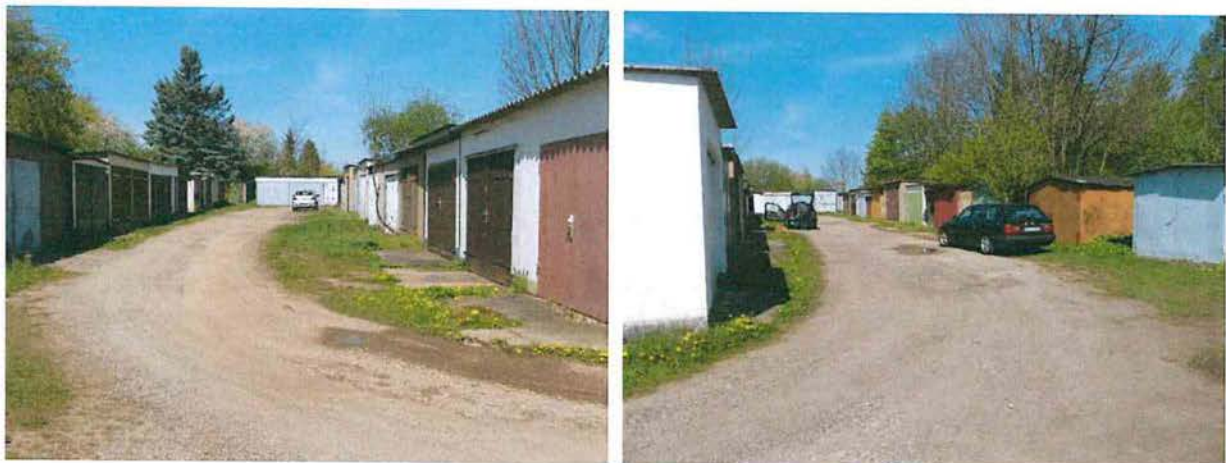
Abb. 2 und 3: Blick von Süden in die beiden Erschließungswege des Garagenhofs
